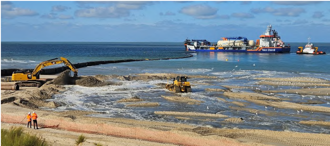
Figuur 1: Vox Apolonia aan het walpersen. Werkschip Panda heeft de Vox Apolonia verbonden met de leiding.
