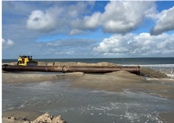
Foto 1: Zand wordt via stalen leiding door de Vox Apolonia op het strand geperst
