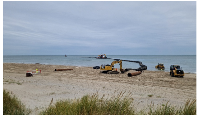
Figuur 2: Drijvende leiding wordt op locatie gelegd.
