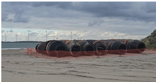
Figuur 2: Drijvende leidingen in de opslag.
